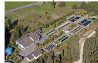
ARA SOMPUNT Pedraces
